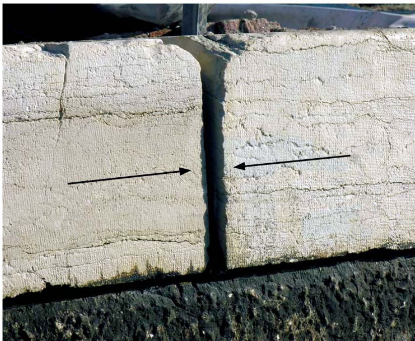
1 LE RIVE INVECE POCO ALLA VOLTA TENDONO A CROLLARE - FOTO: © GIGIO ZANON
